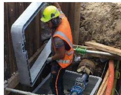
Installation chambre modulaire
